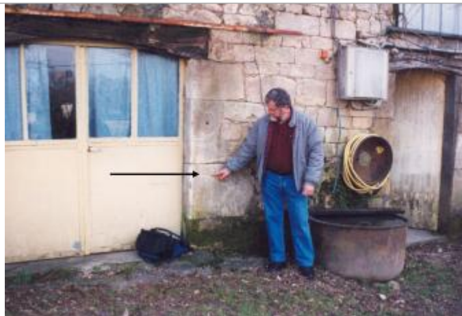
Vue sur un bâtiment qui porte un repère de crue non daté
