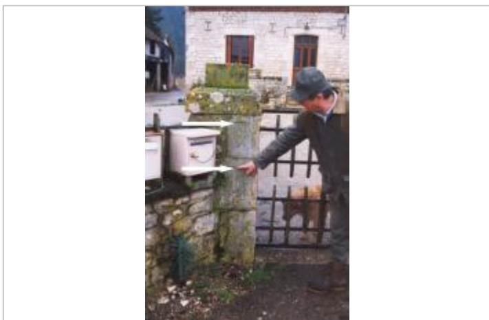
Vue sur un pilier de portail d'entrée qui porte les repères des crues.
