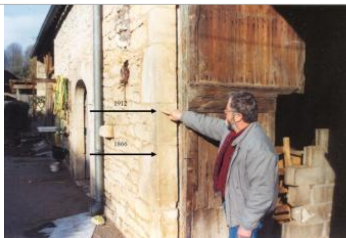
Vue sur un bâtiment qui porte les repères des crues. Les deux repères se distinguent difficilement sur la photographie
