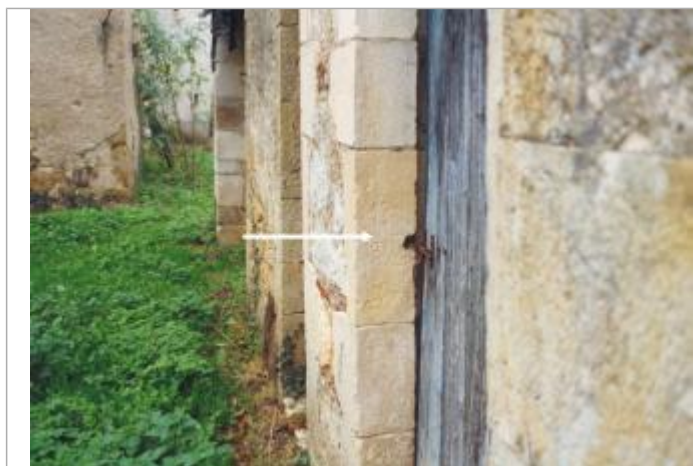
Vue sur un bâtiment qui porte un repère.
