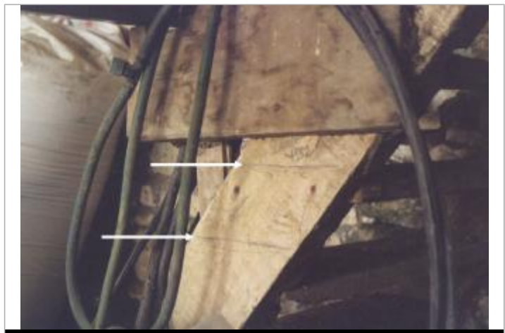
Vue à l'intérieur d'une grange qui porte les repères des crues.
