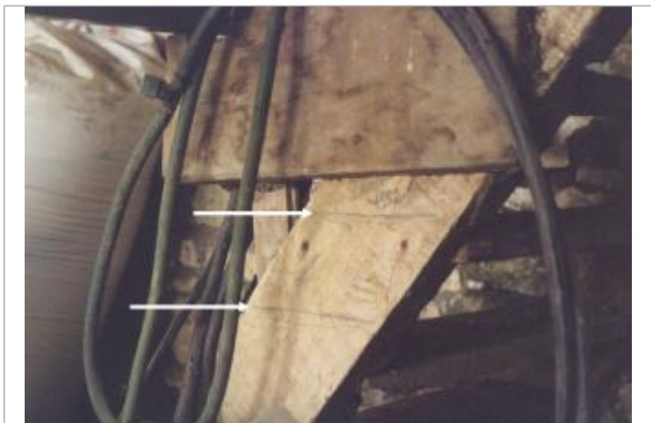
Vue à l'intérieur d'une grange qui porte les repères des crues.
