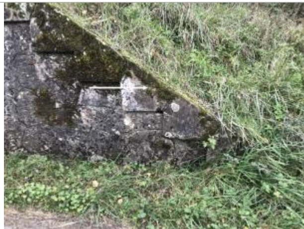
Vue sur le passage de la D 80 sous la voie ferrée.
