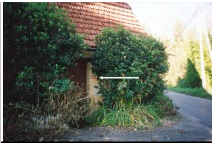
Vue sur un bâtiment qui porte un repère de la crue.
