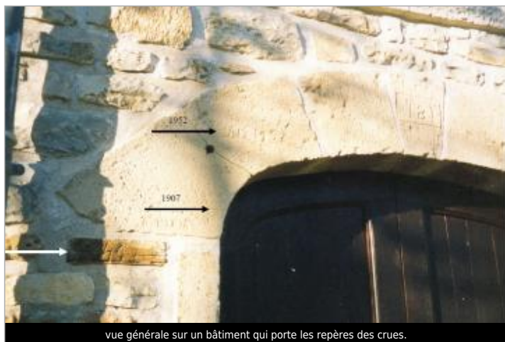
vue générale sur un bâtiment qui porte les repères des crues.
