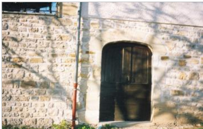
vue générale sur un bâtiment qui porte les repères des crues.
