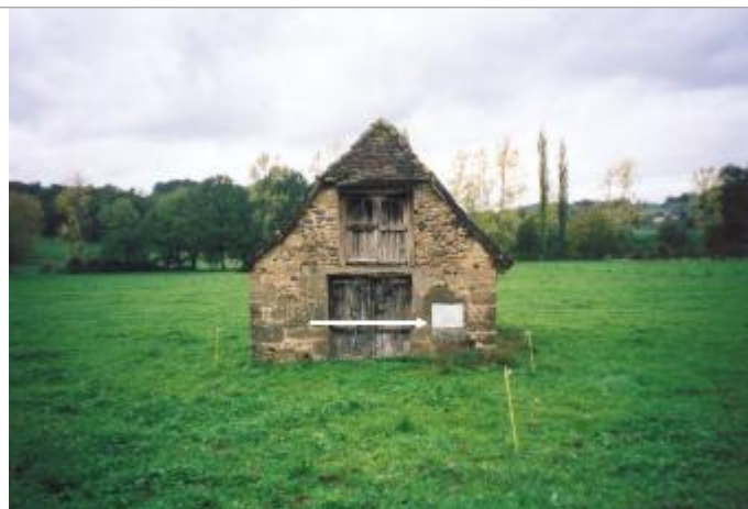
Vue générale sur un bâtiment qui porte un repère
