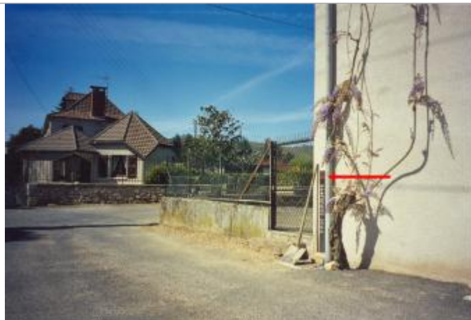
Vue vers l'aval
