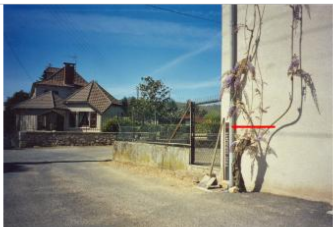
Vue vers l'aval sur un repère
