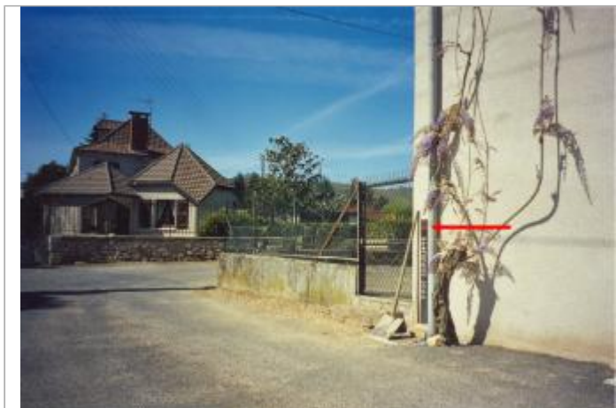
Vue vers l'aval
