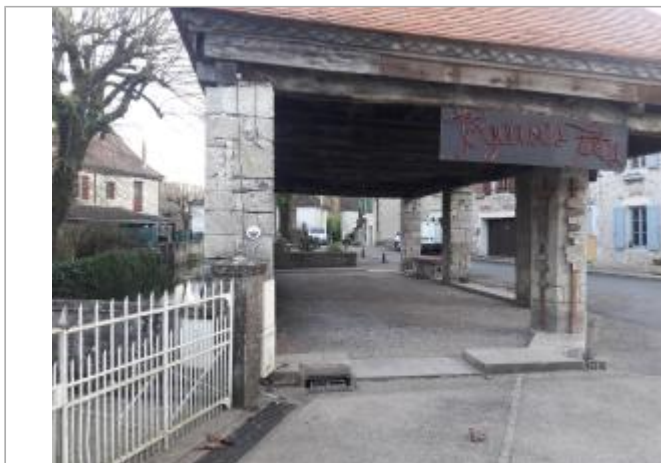
halle de Creysse
