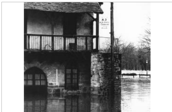
Vue sur l'auberge de jeunesse. La photographie a été prise pendant la décrue, comme en témoigne la trace d'humidité (flèche).
