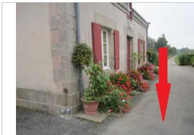
terre-plein de l'écluse
