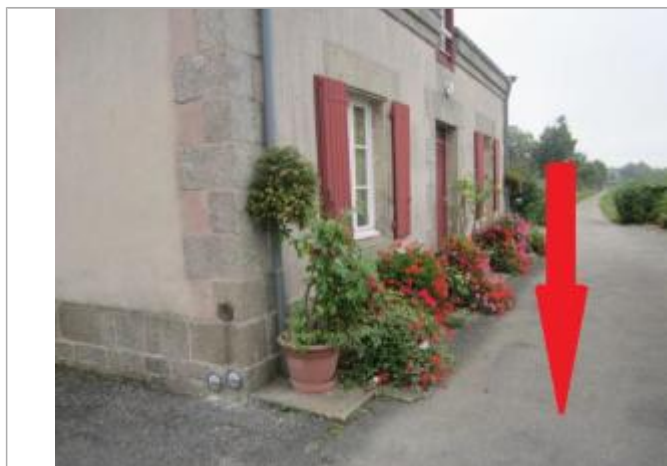
terre-plein de l'écluse
