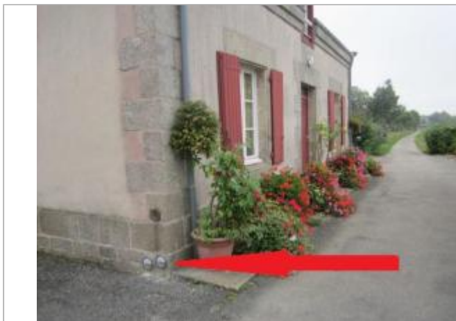
Maison éclusière n°2 Lestitut
