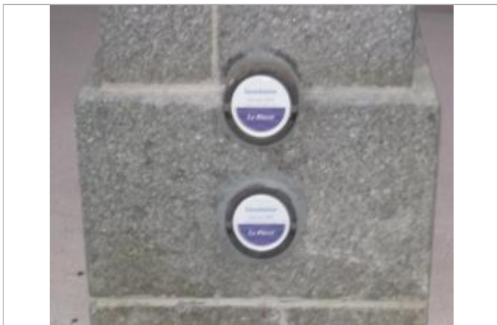
repère normalisé (celui en dessous)_Les Halles - rue des Halles
