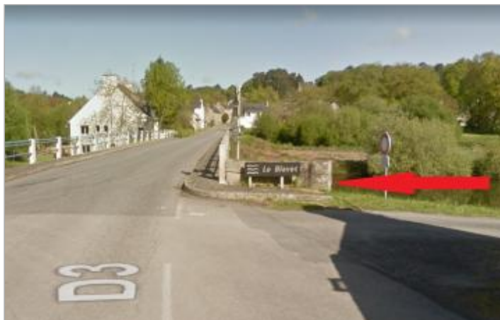
Pont de RD 3 à Pont-Augan
