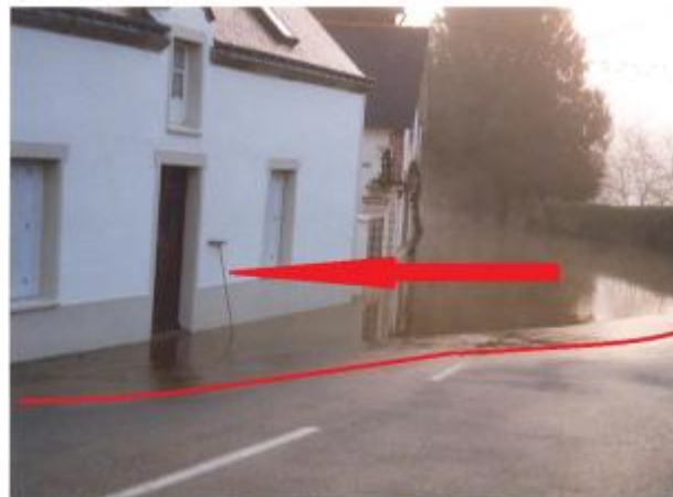
route et maison à Pont-Augan (Baud)
