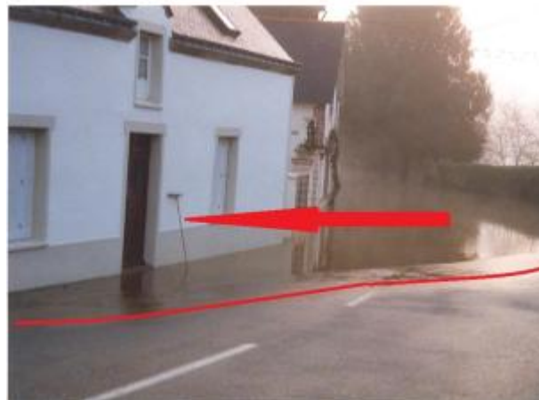
route et maison à Pont-Augan (Baud)
