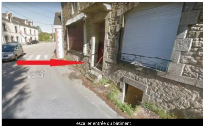
escalier entrée du bâtiment
