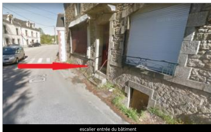
escalier entrée du bâtiment
