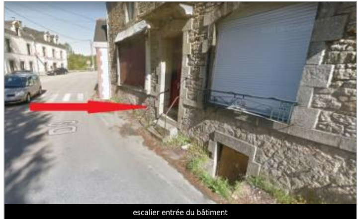
escalier entrée du bâtiment
