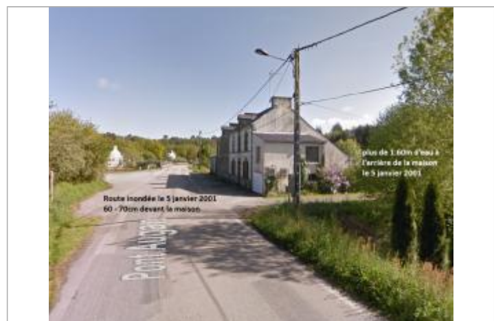
Inondation RD 158 le 5 janvier 2001
