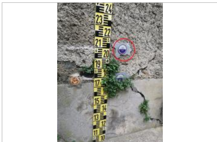
Environ 2m10 au niveau de l'échelle.
