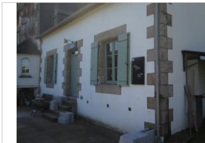
Maison éclusière en 2022
