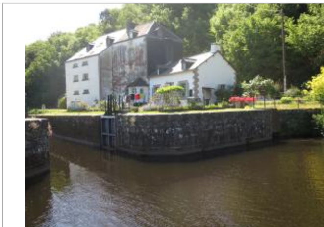
Site de la maison éclusière n°4 Le Roc'h en 2022
