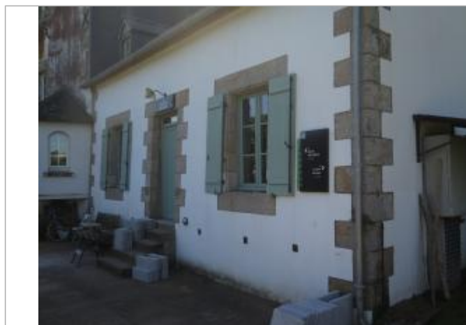
Maison éclésièrè en 2022
