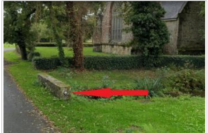
muret à coté de la chapelle de Gohazé
