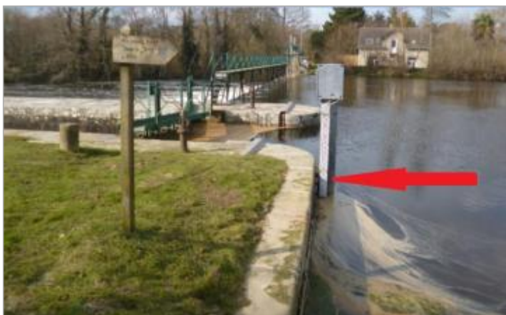
Echelle limnimétrique sur le bajoyer de l'écluse
