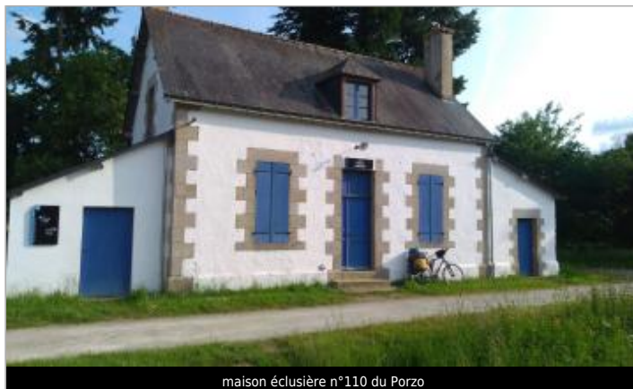
maison éclésièrre n°110 du Porzo
