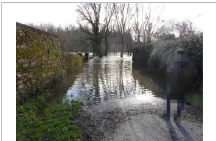
Vue sur la route inondée
