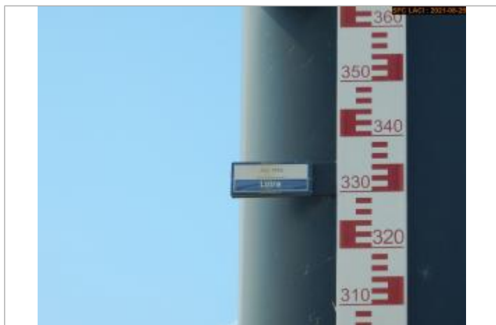
Vue du repère rapprochée en 2021
