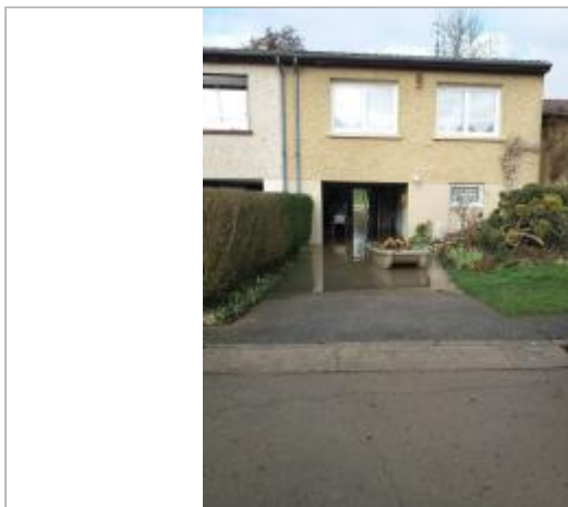
Garage d'un particulier, n°4 lotissement Le Village
