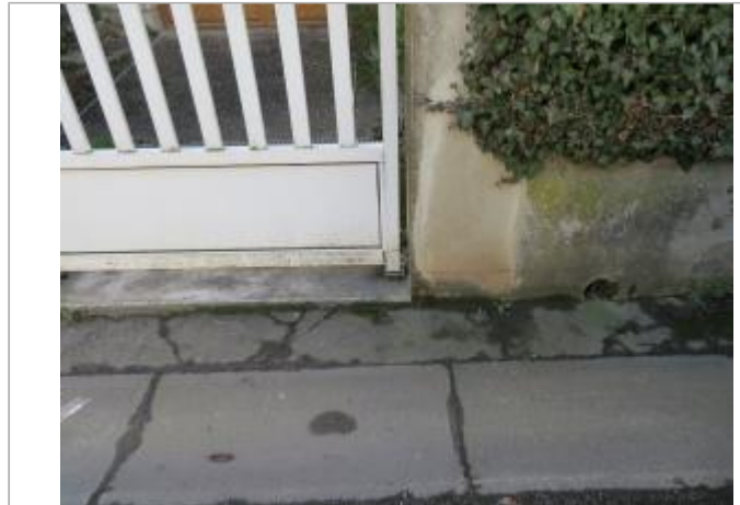
Mur à droite du portail d'entrée
