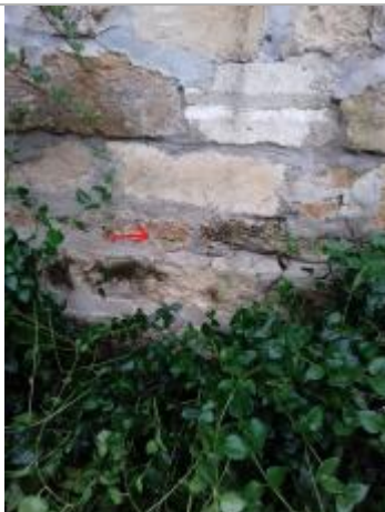
Marque sous la tuile du muret
