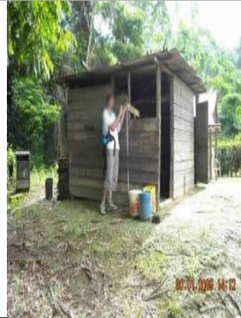
Mur sur le côté droit, sur le chemin d'accès à la rivière
