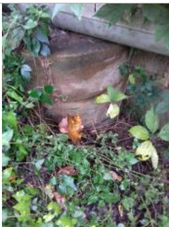
Sur le pont côté amont rive gauche, sur le mur en retour arrondi de la culée
