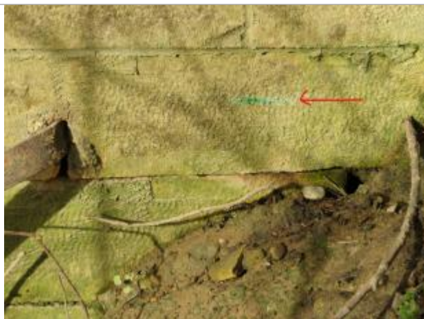
Marque sur le mur en amont de la culée du pont, sous la corniche
