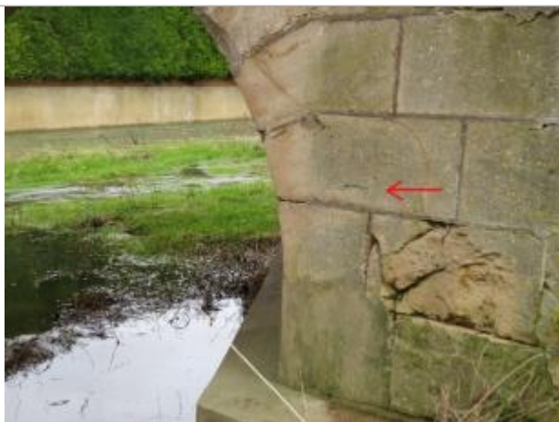
Marque peinte en retour de la culée du pont en rive gauche à l'aval
