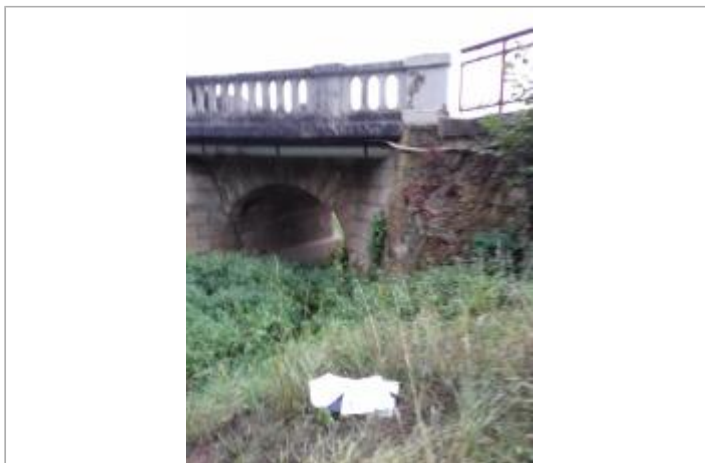
Aval rive gauche de l'ouvrage sur la RD20
