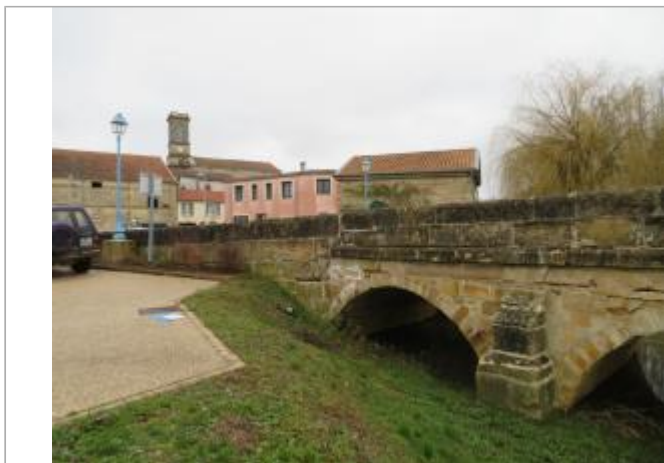
Aval du pont, RD
