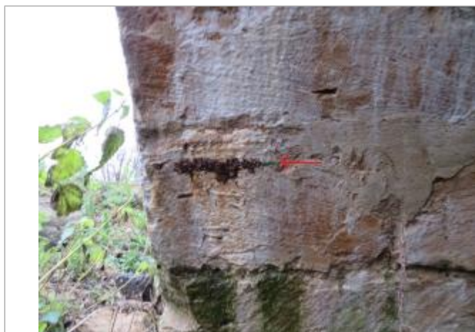
Marque sur la culée de la 1ère arche du pont, peinte à l'intérieur de la voûte, aval RD
