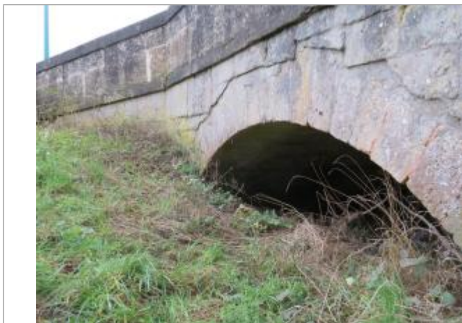
Aval du pont de la rue du Pont
