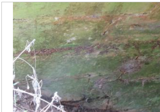
Marque située sur la 1ère arche du pont en partant de la rive droite
