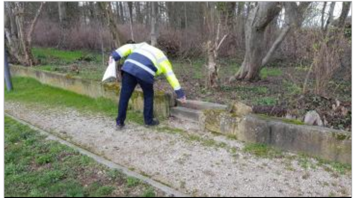
Bordure de trottoir
