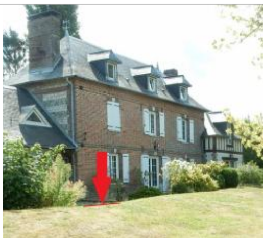
Laisse de crue sur le sol au sommet du talus de protection derrière la maison, face au fleuve.
