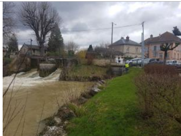
Aval de l'ouvrage de décharge
