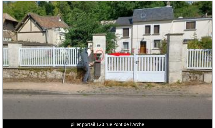
pilier portail 120 rue Pont de l'Arche
