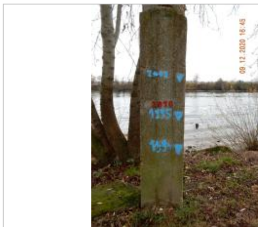
crue du 27 janvier 1994
