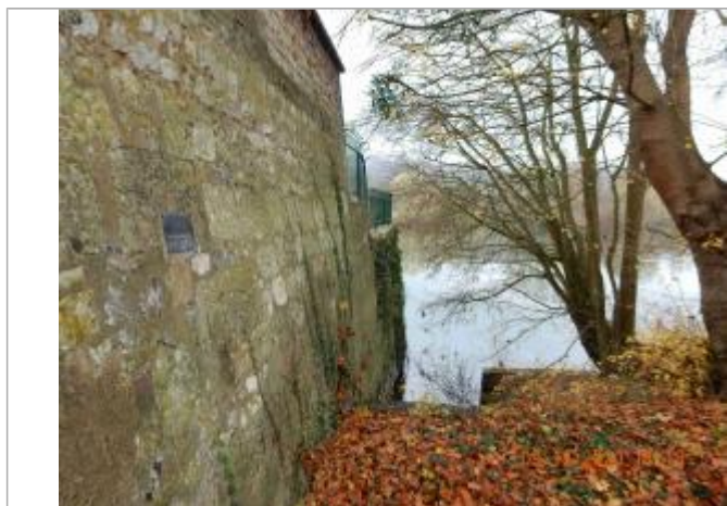
Repère sur le mur Est de la propriété
