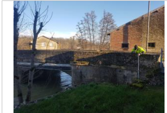
Aval du pont sur la Saulx
