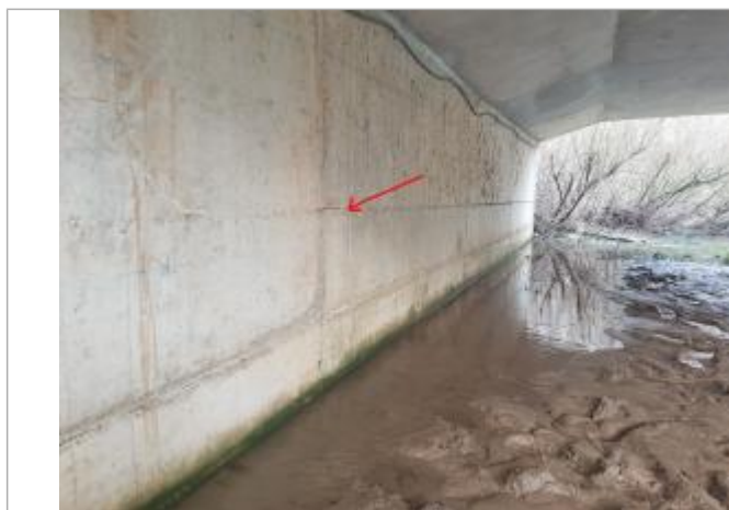
Marque sous le pont de la culée rive gauche, vers le milieu
