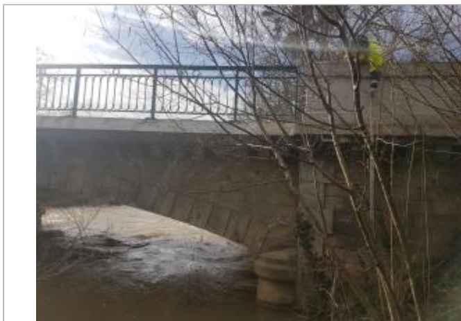
Pont sur la Saulx sur la Route d'Alliancelles, amont RD
