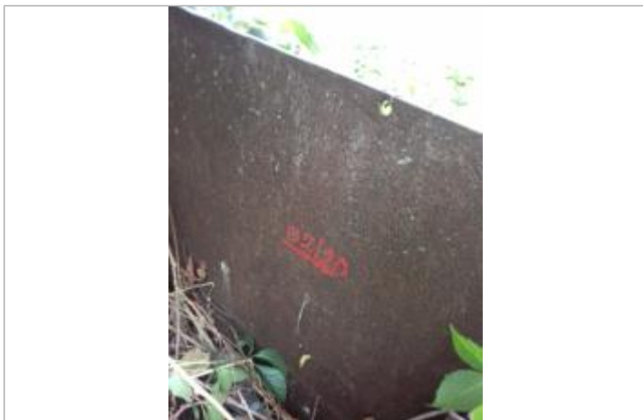
Marque rouge sur le petit soutènement constitué de plaques acier sur le bord de la rivière
