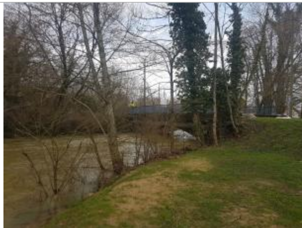
Pont de la Rue du Port, sur la Saulx
